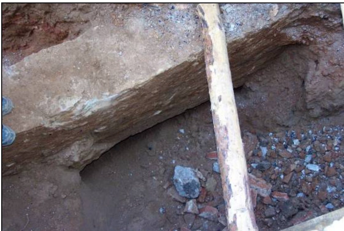
foto 1a Troballa del mur lateral sud-oest (UE 104) del pont UE 123.
