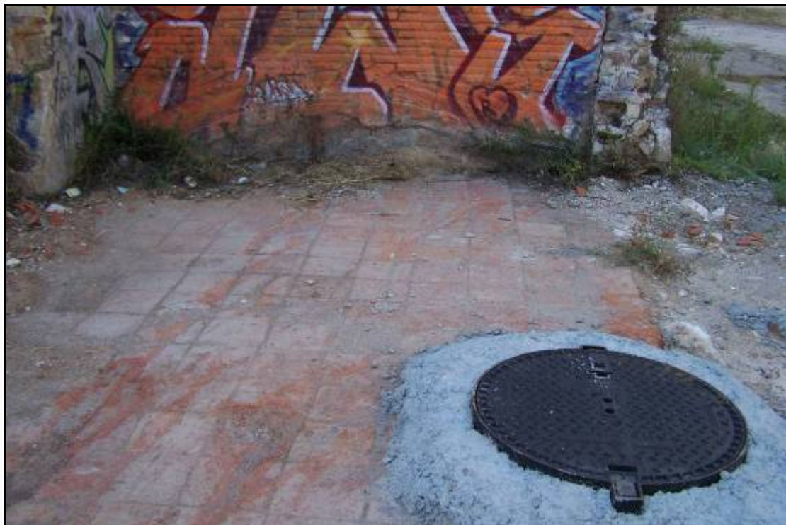
foto 1a Entrada del pou d'accés al Rec ja terminat, amb la finca al costat.
