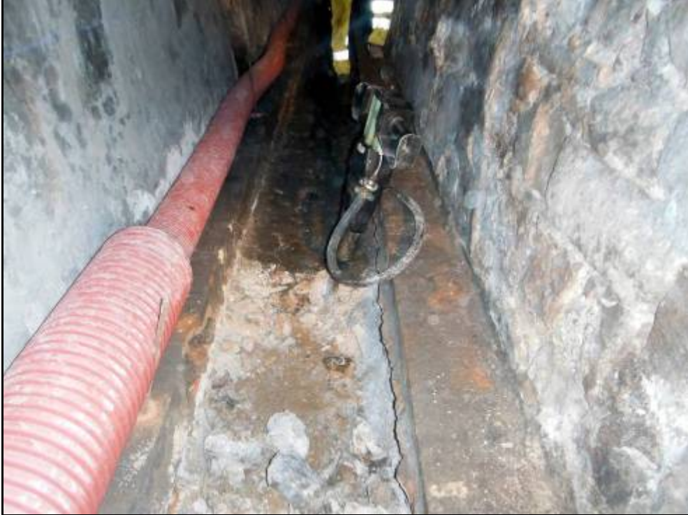
☐ foto ☐ ra ☐ a ☐ ☐ Rebaix de la solera del col·lector existent al passeig Lluís Companys.
