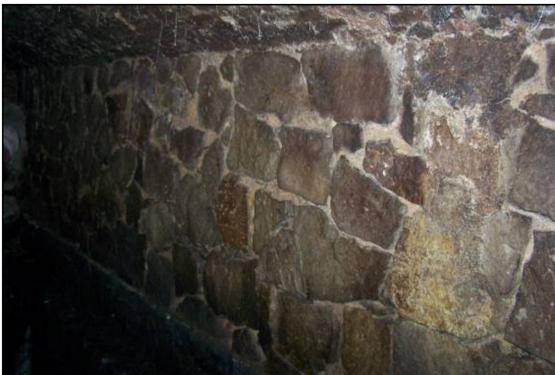
foto 1a Alçat de la paret del Rec (UE 205), obrada amb pedres de grandària irregular molt bé perfilada, unides amb morter de calç blanc.
