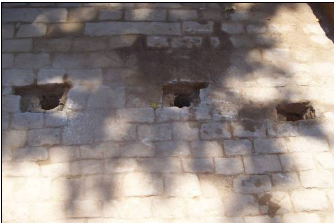
Imatge 2 Finalització dels treballs de foradament en el pont.
