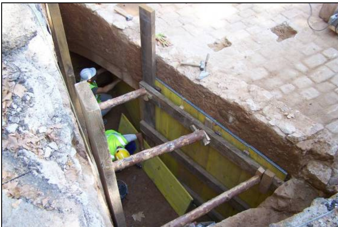
foto 2a Encofrat del lateral de l'arcada sud-oest del pont per contenir el morter.
