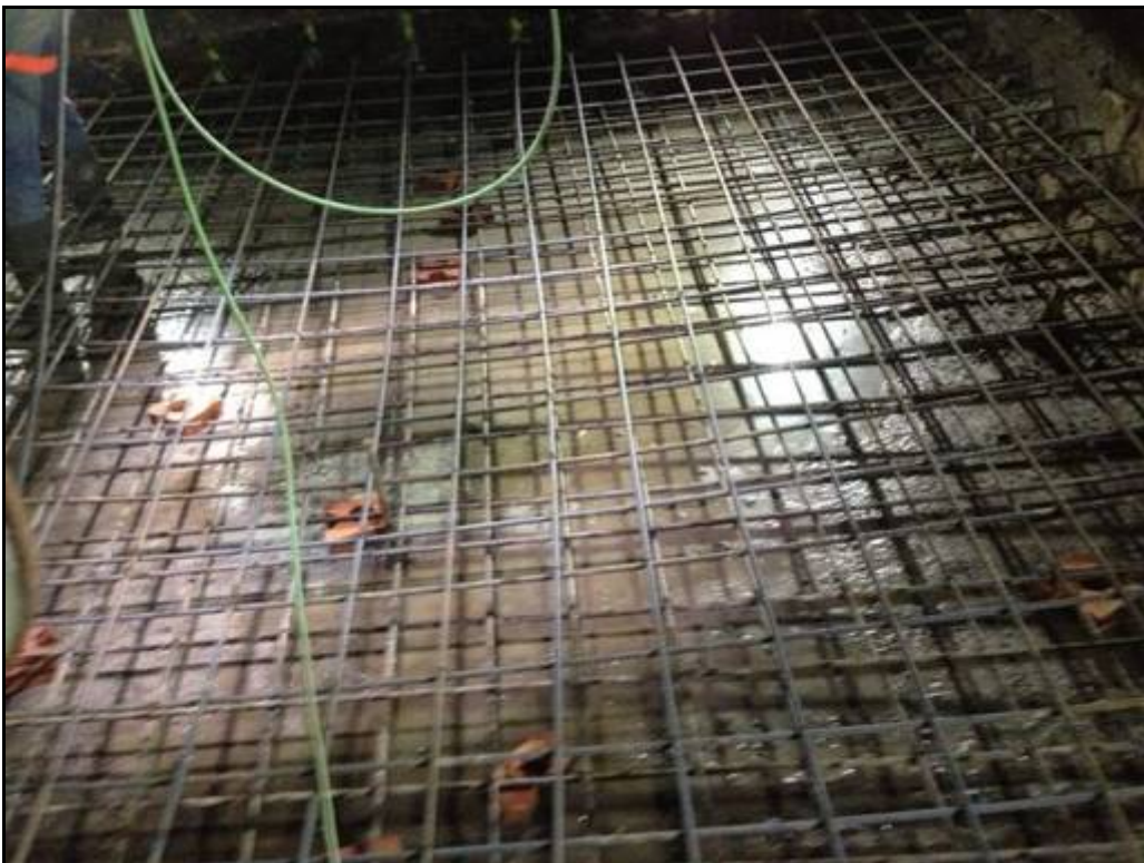
0635 Fotografia Preparació per formigonar la solera del Rec després de la neteja d'aquest tram.
