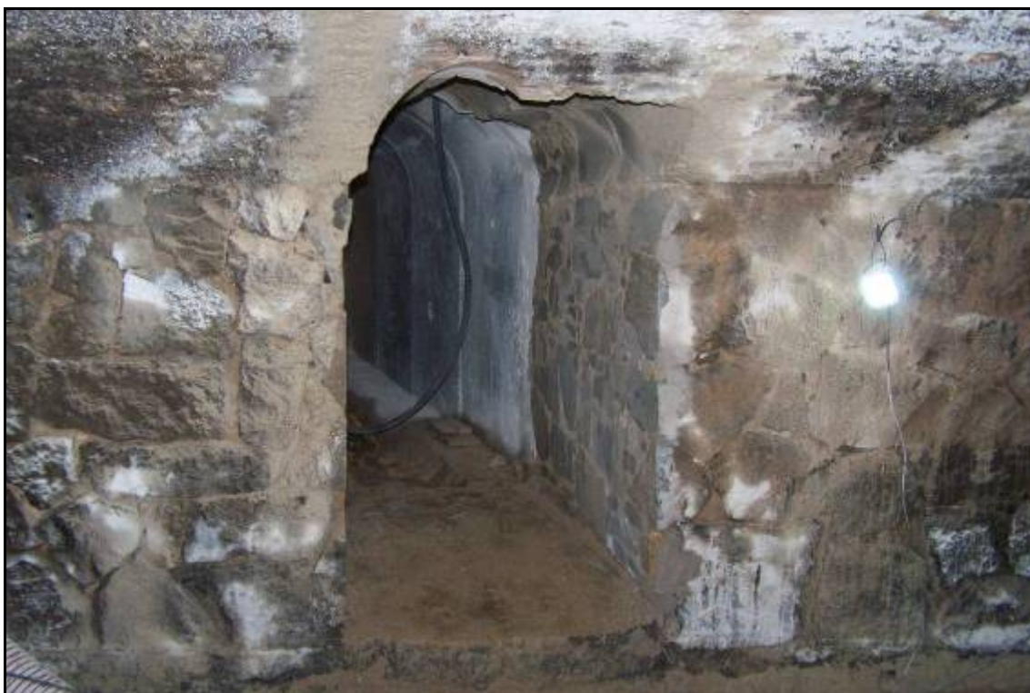
0000000000 Paret del Rec (UE 205) perforada, amb la connexió del nou col·lector.
