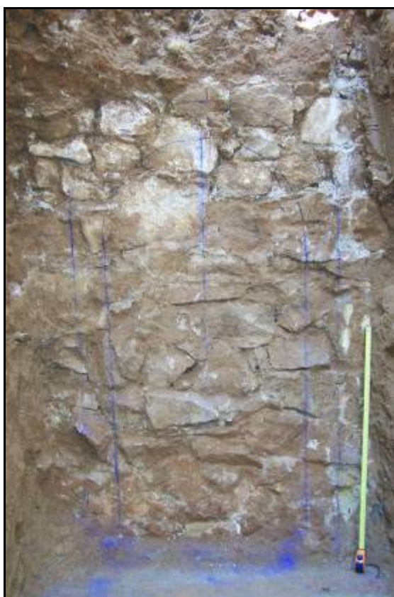
foto 1a Marca prèvia de la perforació que es va fer a la paret del Rec per unir-lo amb el nou col·lector.
