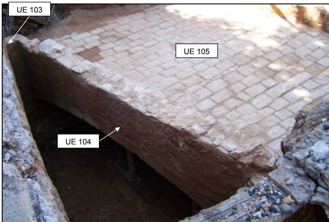
foto a Vista des del costat sud-oest del pont netejat en la seva totalitat.
