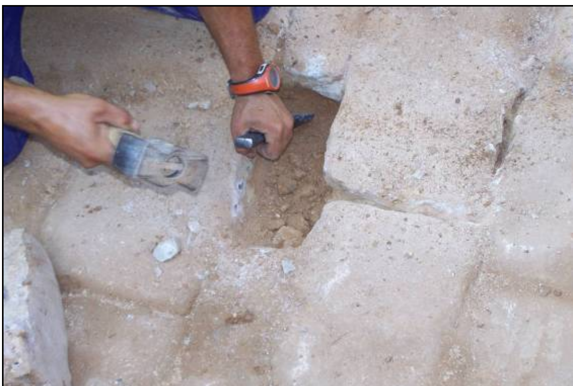
Imatge fotogràfica Extracció manual de les llambordes del pont per injectar morter a la part inferior.
