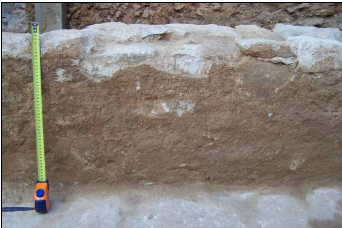
foto 11a Arrebossat de calç al mur UE 104.
