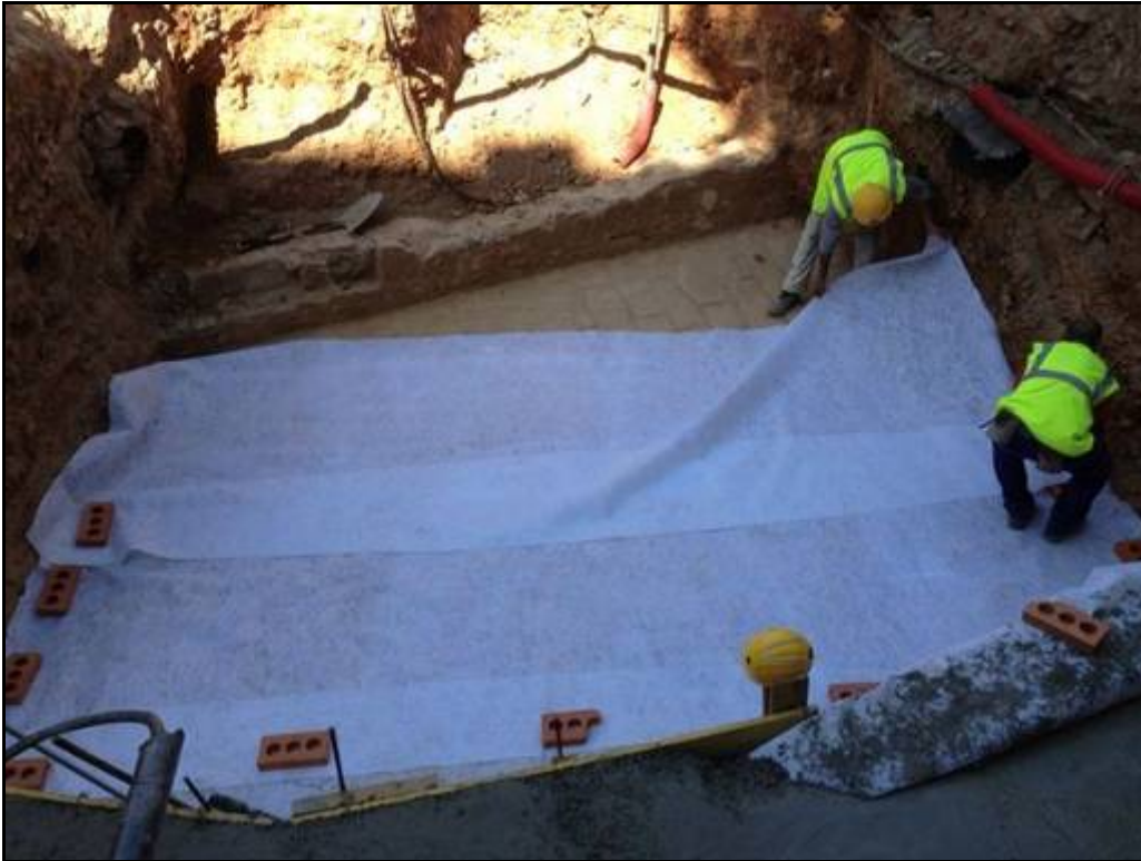
foto ra ta ta ta Col·locació del geotèxtil per protegir el pont abans del seu cobriment final amb terra.
