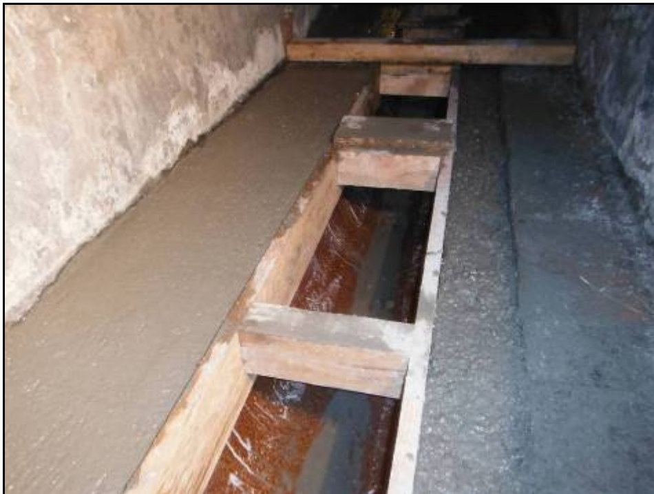
Foto 11 Reconstrucció de la nova solera a l'antic col·lector existent al passeig Lluís Companys.
