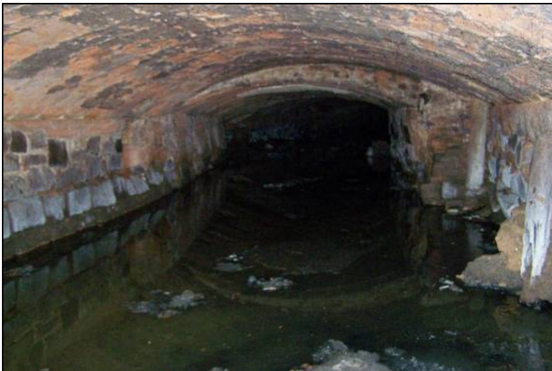
Foto 1a Interior del Rec, en direcció sud-est, vers el carrer del Rec Comtal.
