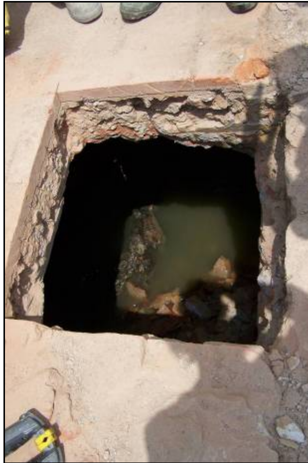
foto 1a Pou d'accés obert a la coberta del Rec.
