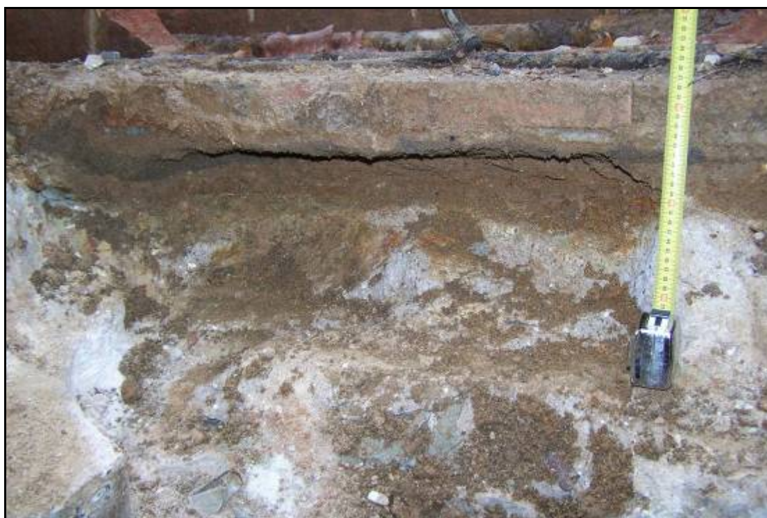
□foto□ra□a □□□Vista en secció de la tubular de FECSA trencant el baluard per la part superior.
