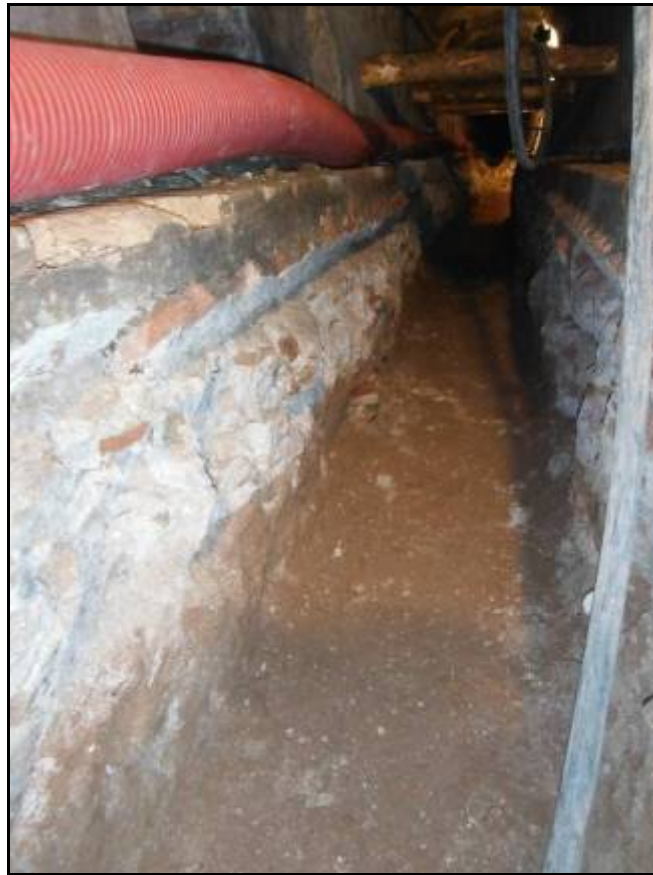
Foto 10 Rebaix de la solera del col·lector existent al passeig Lluís Companys finalitzat.
