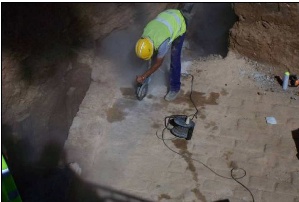
Imatge fotogràfica Desmuntatge amb talladora radial de la part del pont UE 126 afectada.
