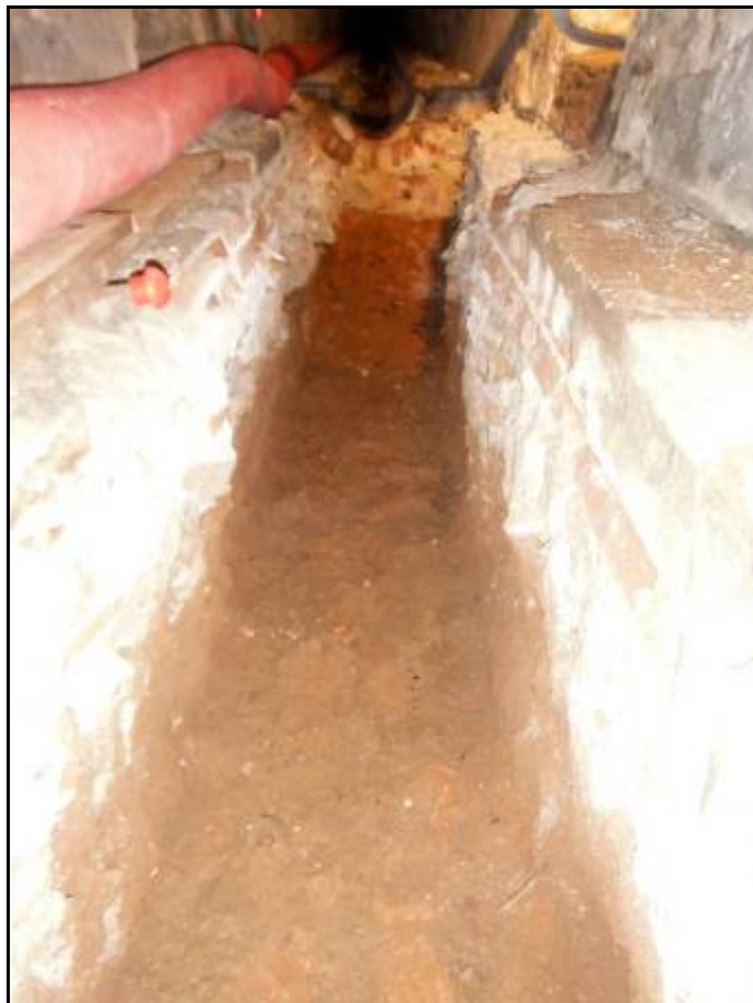
☐ foto ☐ ra ☐ a ☐ ☐ Procés de rebaix de la solera del col·lector existent al passeig Lluís Companys fins arribat a la cota requerida.
