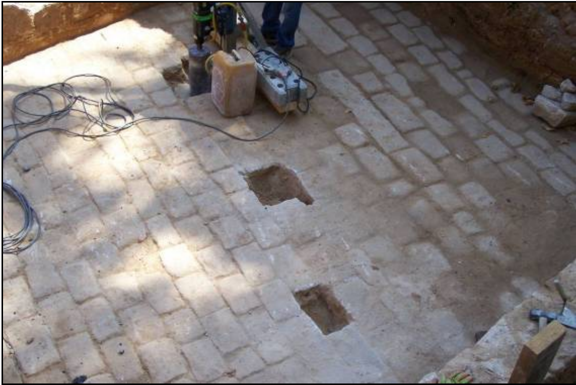
Imatge 1 Foradament mecànic en els tres espais buits de la pavimentació del pont.
