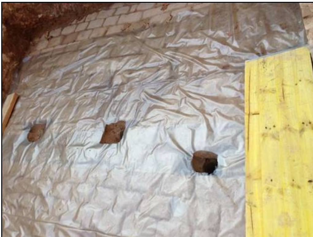
□oto□ra□a □□□Protecció de la pavimentació del pont abans de la injecció del morter.
