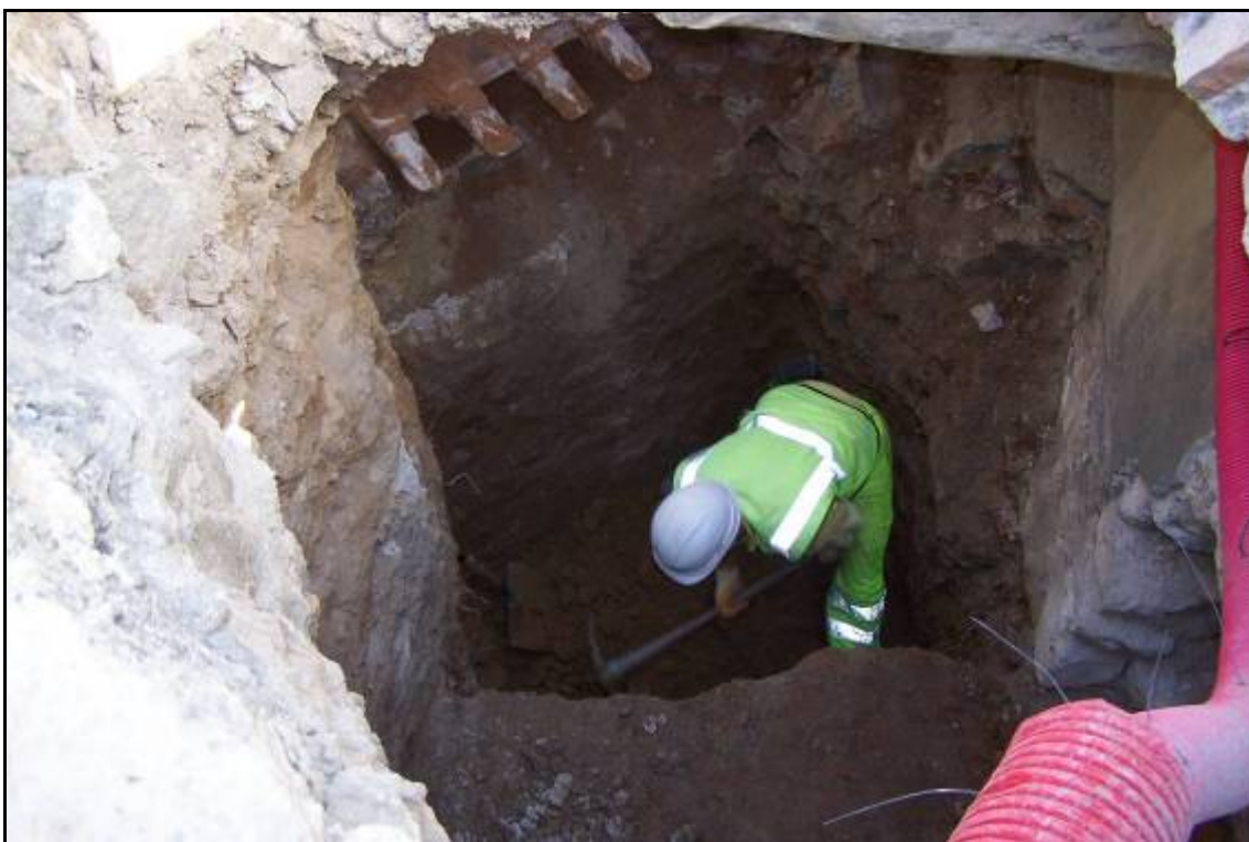
Foto 1a Rebaix manual dels 1'20 metres que faltaven per a arribar al final de la cota requerida per l'obra.
