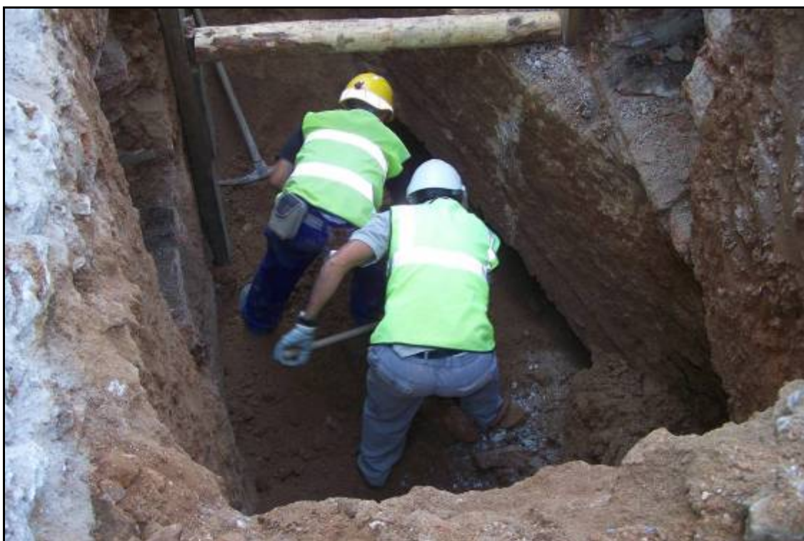
foto 1b Neteja manual del sediment que amortitzava el pont UE 123.
