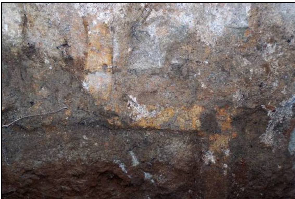
Imatge 101 - Detall del morter acolorit entre les juntures dels carreus del baluard.
