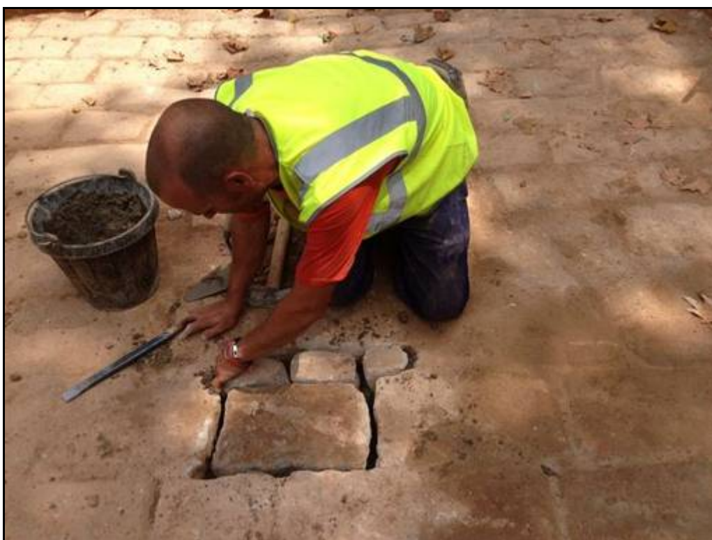
□oto□ra□a □□□Reposició manual de les llambordes extreteres del pont.
