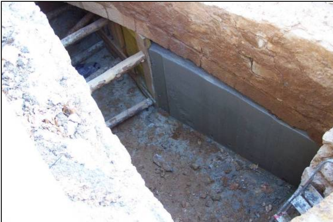
001010111 Retirada dels encofrats laterals del pont després de la injecció del morter.
