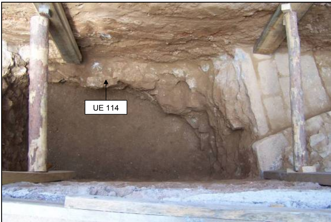
Foto a Vista exterior de la canalització UE 114, just en el tall de la rasa del col·lector.
