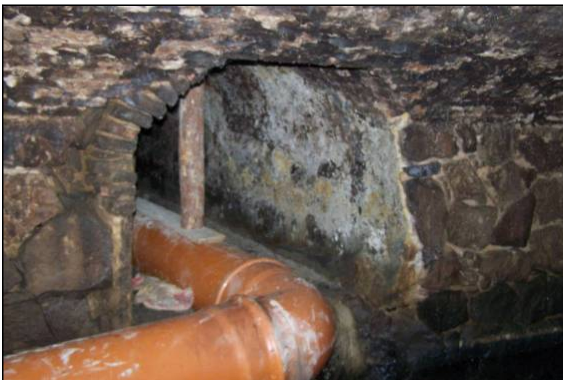
□oto□ra□a □□□Paret del costat oest del Rec (208), perforada per a la connexió amb el col·lector que baixa des del carrer de Trafalgar.
