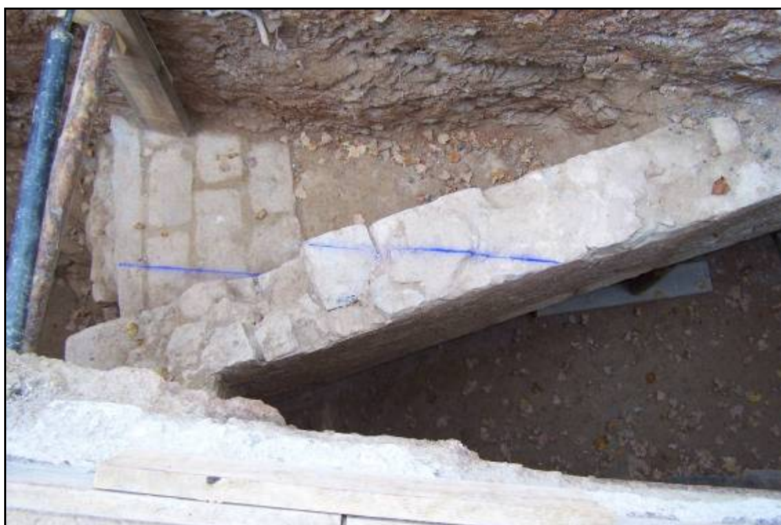
Foto a Senyalització amb cordell blau de la part afectada del pont per les obres.
