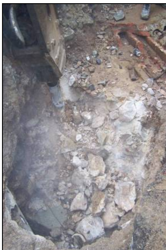
Foto 1a Desmuntatge dels primers 2 metres del mur del baluard.
