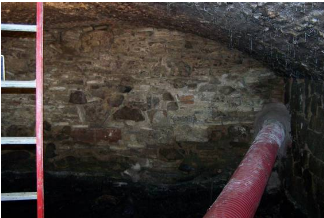
□oto□ra□a □□□Extrem nord-oest del Rec, tapiat a pocs metres del punt on s'havia fet el pou d'accés a l'interior.
