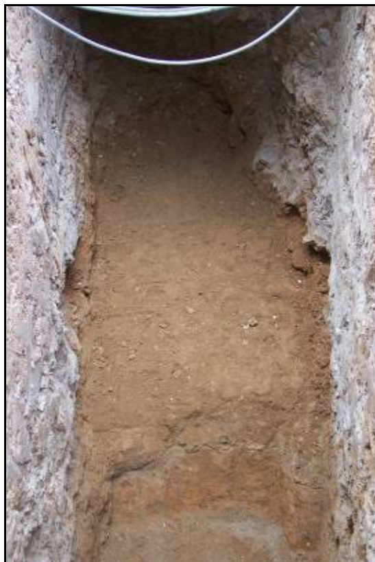
foto 1a Nivell de preparació UE 121 després de l'extracció de les pedres de la calçada UE 122.
