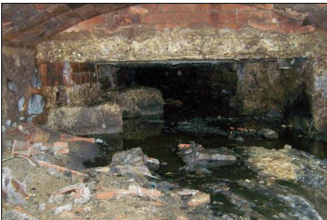
Foto 2a Interior del Rec, en direcció nord-oest, vers el carrer de Trafalgar, amb les cimentacions de la finca construïda al seu damunt.
