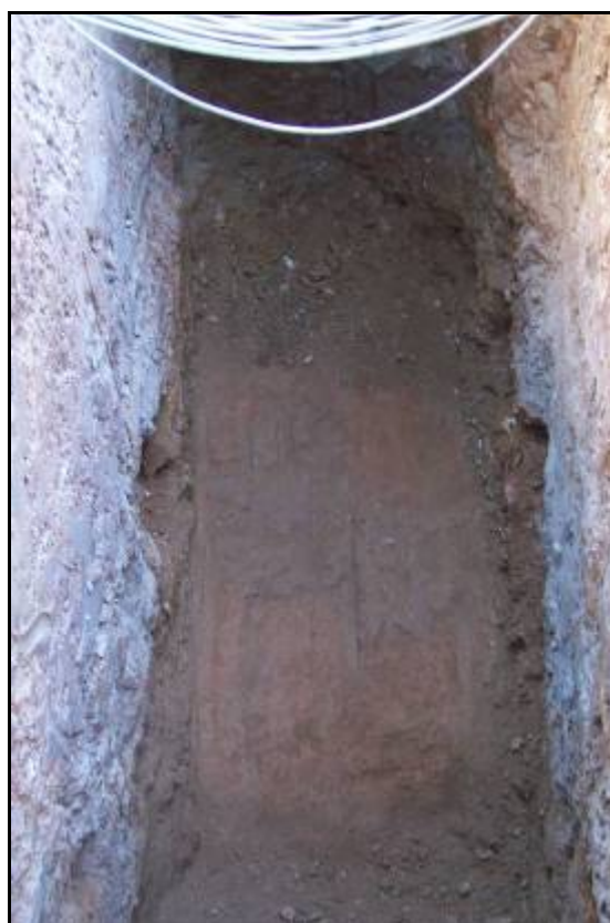
foto 1a Nivell d'argiles (UE 124) després de l'extracció de la preparació (UE 121) de la calçada.
