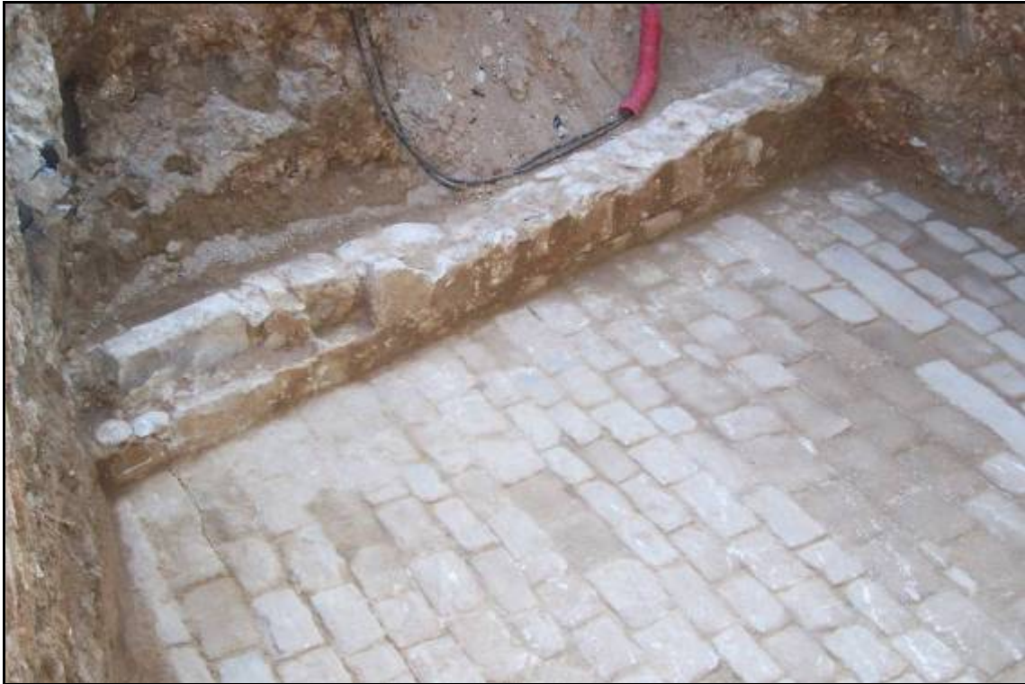
foto 11a Paret lateral nord-est (UE 119) del pont.
