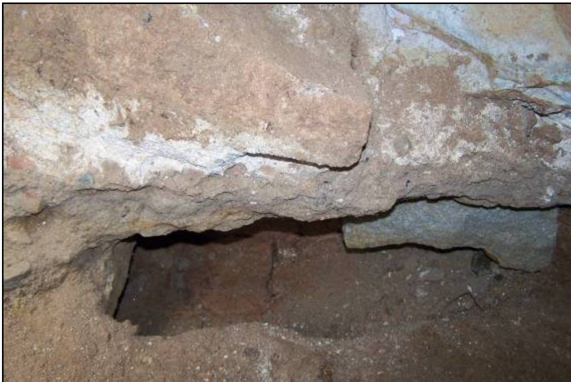
foto 1a Interior de la canalització UE 116.
