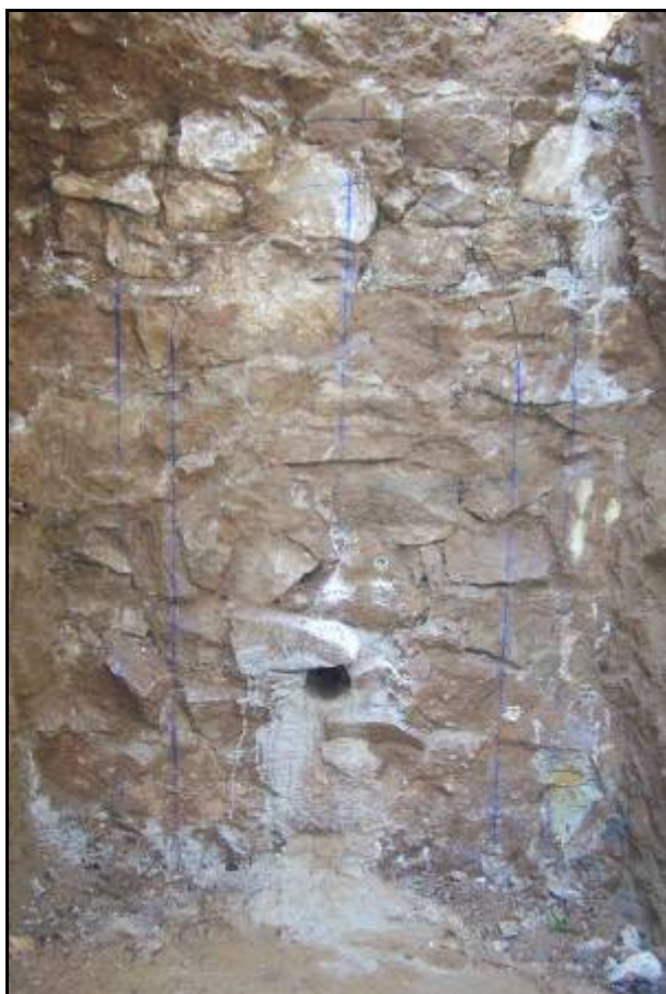
□oto□ra□a □□□Trepanació de la paret del Rec per a poder ficar el ternal i permetre arrossegar els blocs de formigó del nou col·lector dins de la rasa.
