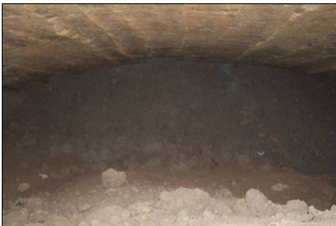
Imatge fotogràfica de la vista per sota del pont, amb la volta superior de l'estructura i el rebliment de terra de l'extrem nord-est.
