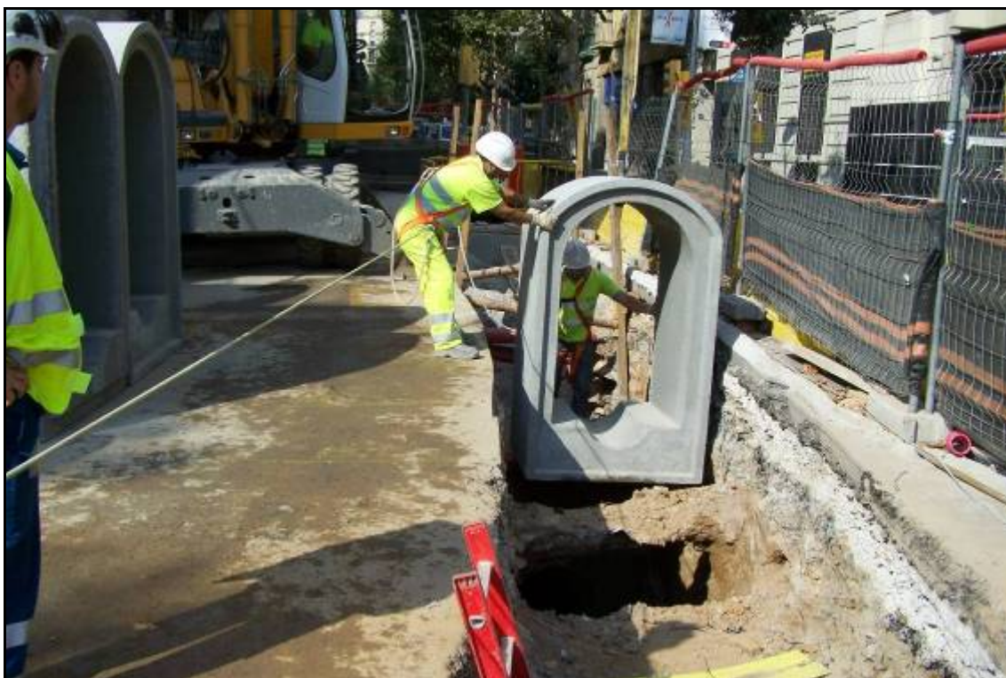
o r a Col·locació dels blocs de formigó del nou col·lector a dins de la rasa.
