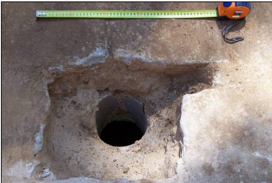
foto 1a detall d'un dels forats efectuats sobre la pavimentació del pont.
