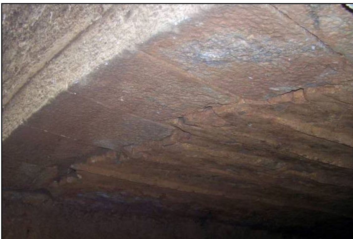
Imatge 01 Empremtes de la cintra de fusta emprada en la construcció de la volta del pont amb les seves dovelles.
