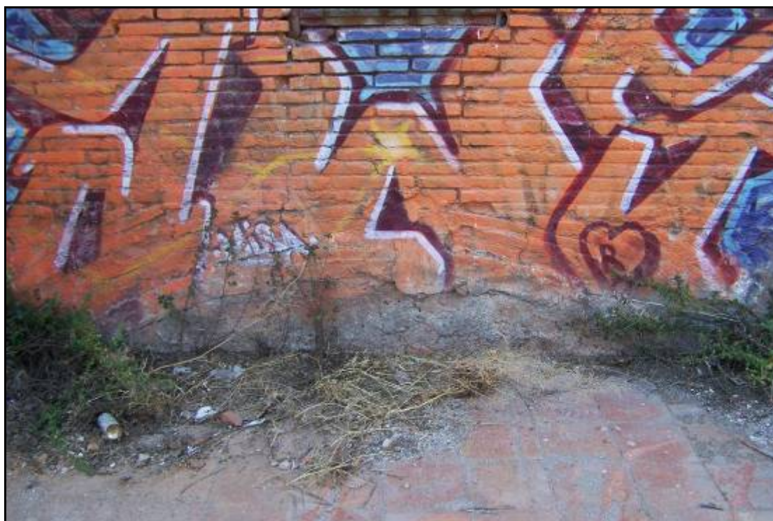
foto ra a Detall de la base de l'edifici on s'observa l'arc de descarrega de la coberta del Rec que passa per sota.
