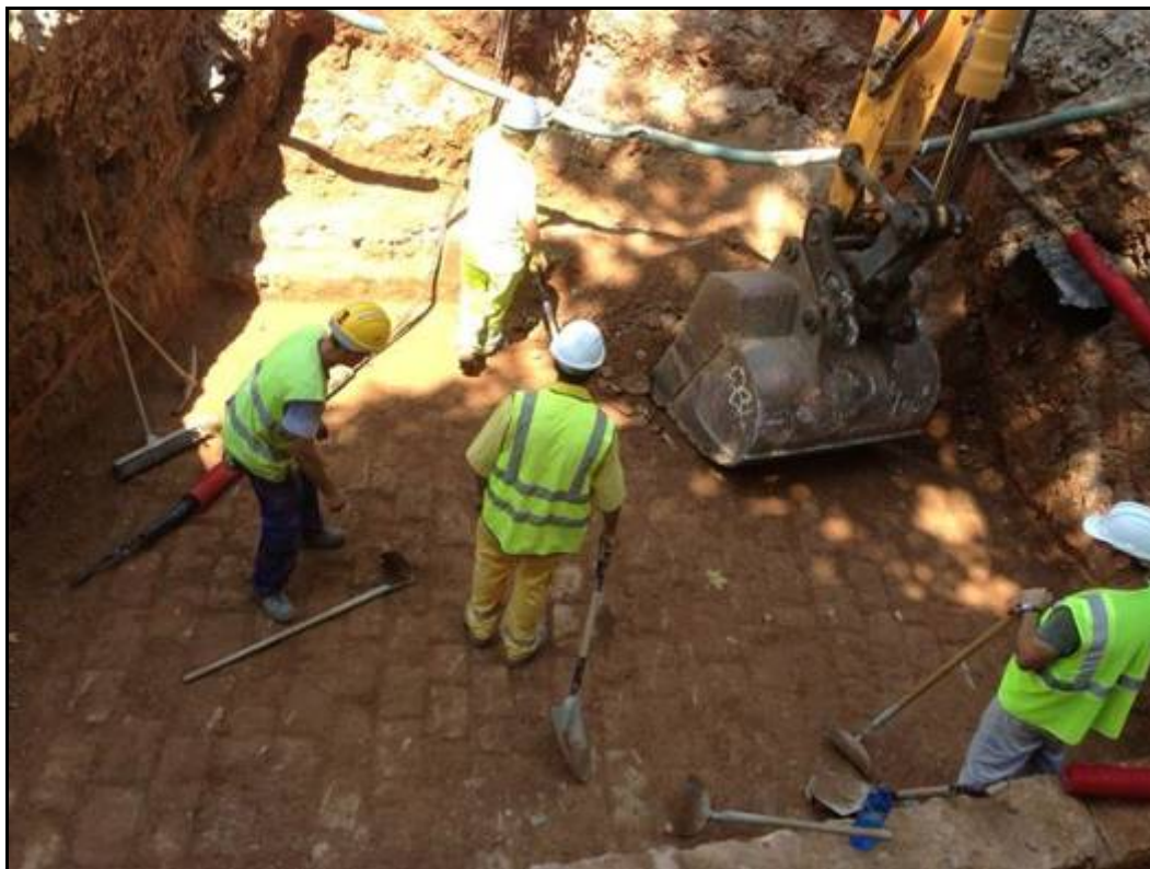
Foto 123 Desenterrament amb màquina giratòria del pont en la seva totalitat.
