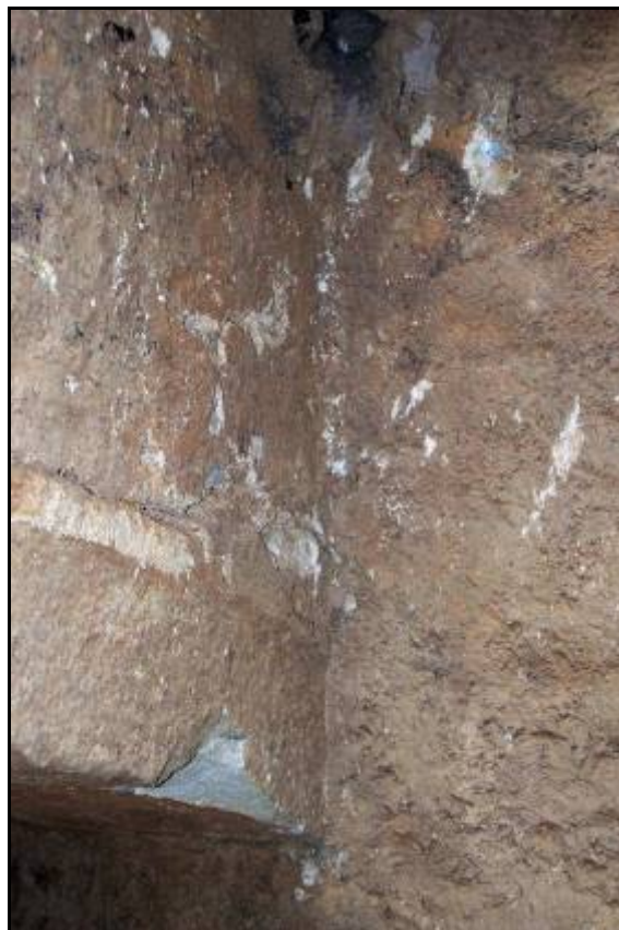
Figura 125. Unió del mur UE 106 amb l'arc del pont, UE 104.
