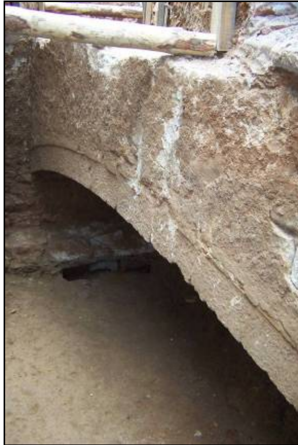
foto 1a Vista general de la canalització UE 116 sota el pont.
