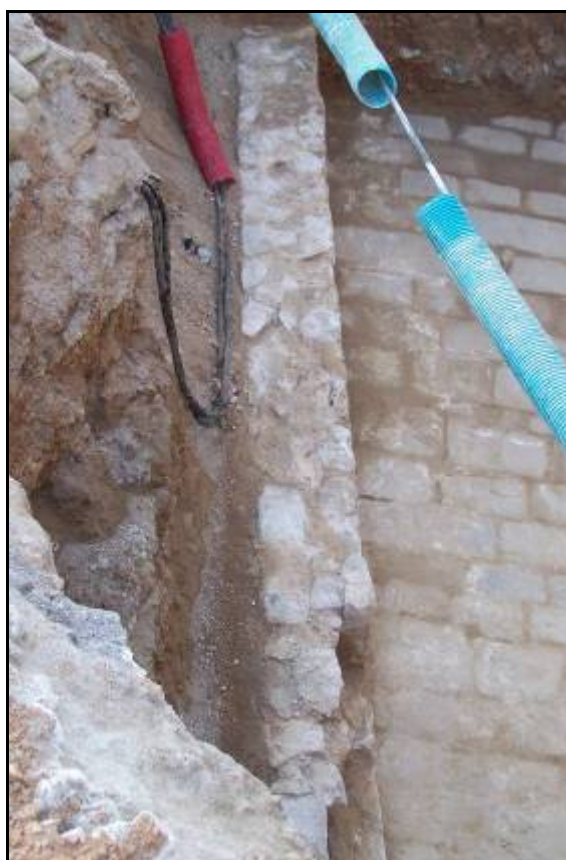
Figura 126. Vista zenital de la paret lateral nord-est (UE 119) del pont.
