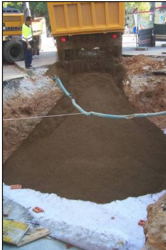
foto ra ta ta ta Aportació de sauló per cobrir el pont a sobre del geotèxtil.
